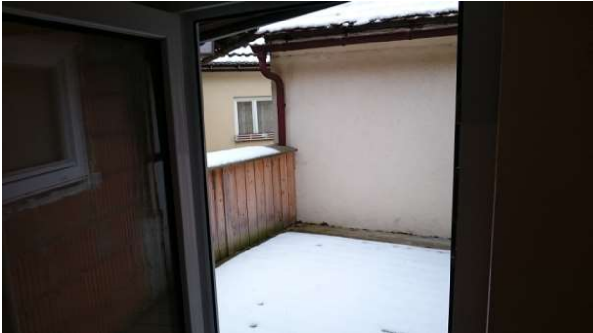
Blick auf den Balkon
